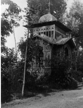
Glorieta del parc de La Gelidense
